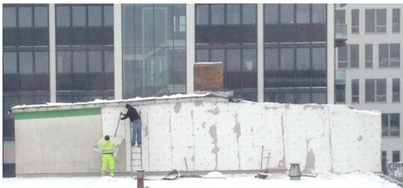
Fotos: Rückbau eines WDVS
