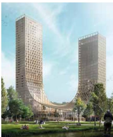
taktile Qualität. Das Material ist besonders im Unterbau sichtbar, wo Böden, Säulen und die Dachkonstruktion aus Holz sind. Nicht alle Teile des Gebäudes bestehen aus Holz. Die am stärksten belasteten Bauteile sind aus Beton gefertigt. Um die Schallübertragung zu reduzieren, ist die Oberseite der Böden im Wohnbereich ebenfalls aus Beton gefertigt. Die Süd- und Westfassade von „The Dutch Mountains“ sind mit Sonnenkollektoren ausgestattet.
