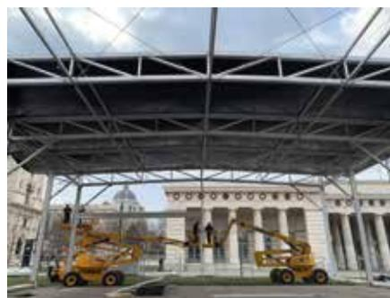
Getragen wird die textile Hülle von einem Alu-Konstrukt
